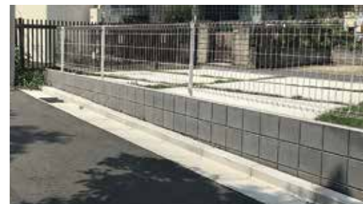
[新設フェンス]
