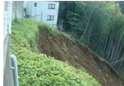
市内で発生したがけ崩れの様子
