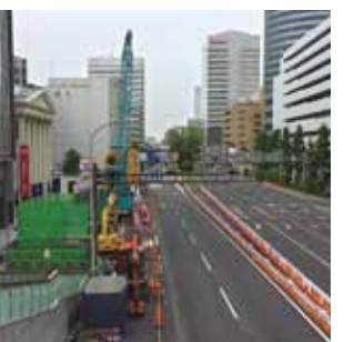
工事が進む新横浜駅周辺
