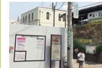
工事が始まった菊名駅西口
