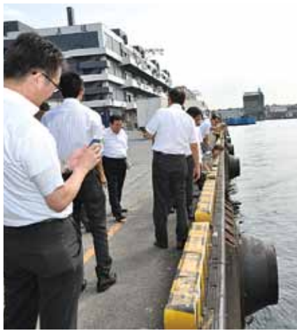
港湾施設の老朽化を視察 (H24年8月)
