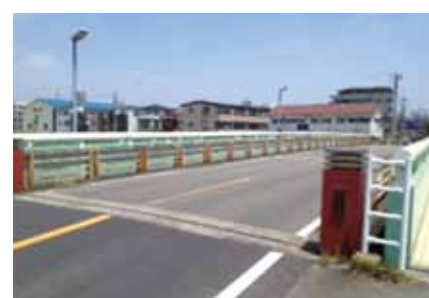
1965年竣工の矢上川・一本橋 (港北区日吉と川崎市幸区に跨がる)
